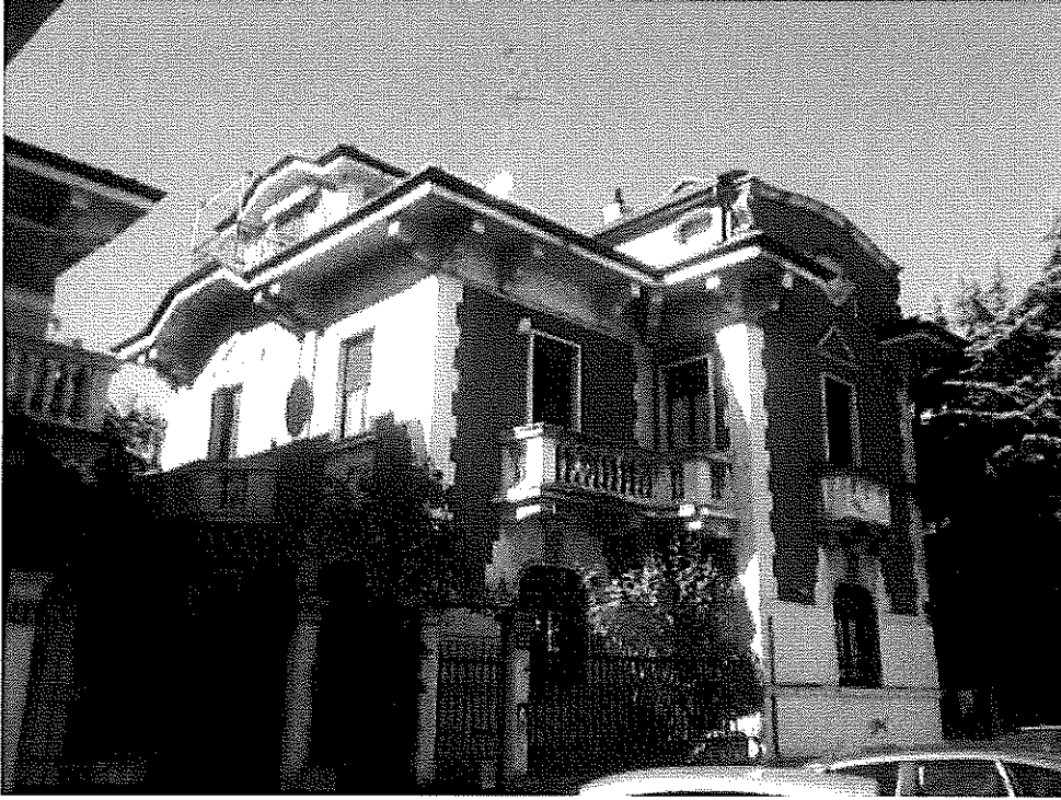
5 Recupero sottotetto a Milano
