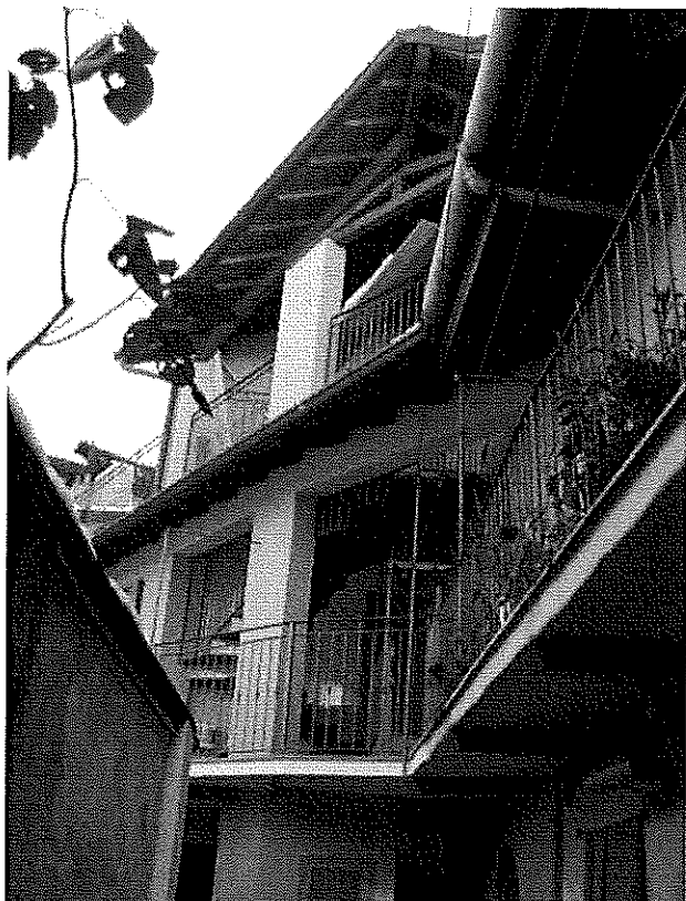
1. Recupero sottotetto, Corte Via Roma, Cormano
